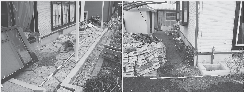
図13 前沢区西部地区新町の盛土住宅の被害
