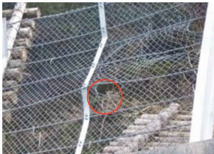
写真-6.1 落石が金網を突き抜けた事例
