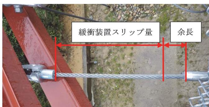
写真-5.12 緩衝装置のスリップ状況
