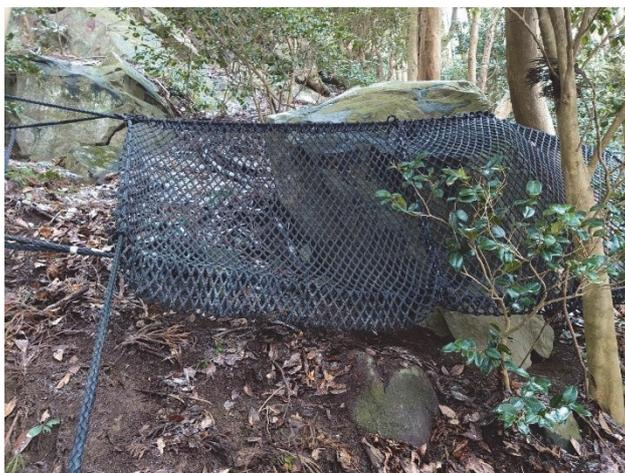
写真-7 落石対策に利用した場合の例
