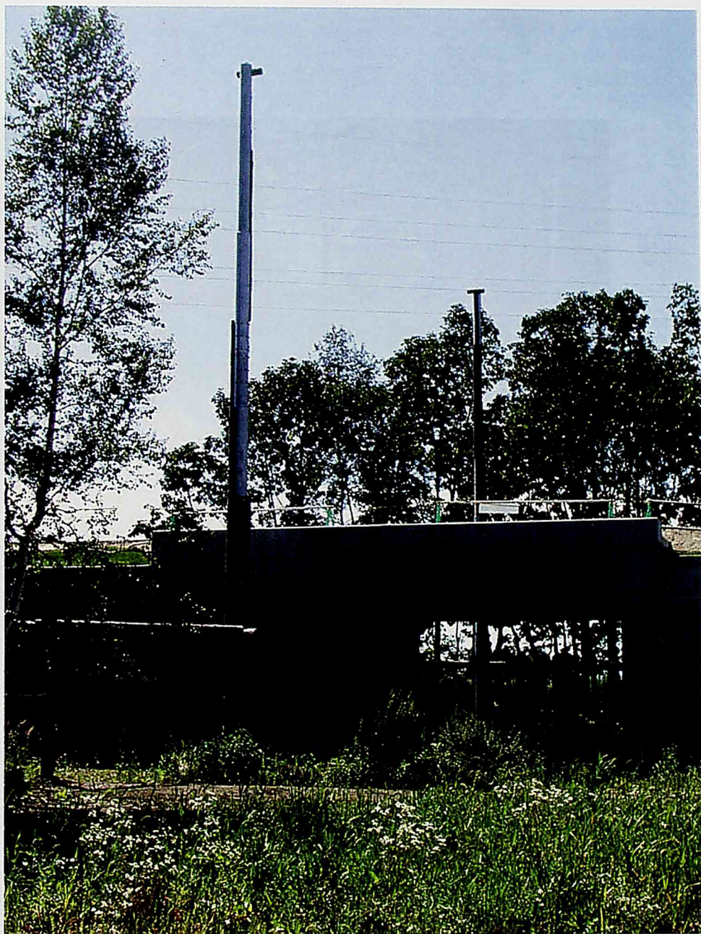
図 5-1 道路両側に設置されたモモンガ横断用支柱
