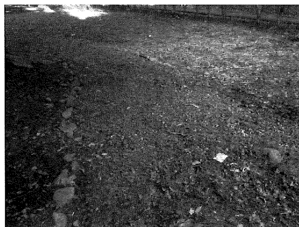
図1 荒廃した散策路
