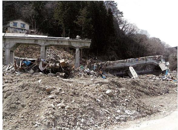
Photo 4. 津波の直撃によって倒壊した北リアス線島越駅付近の高架橋, 威力のすさまじさを物語る (2011年4月3日).
