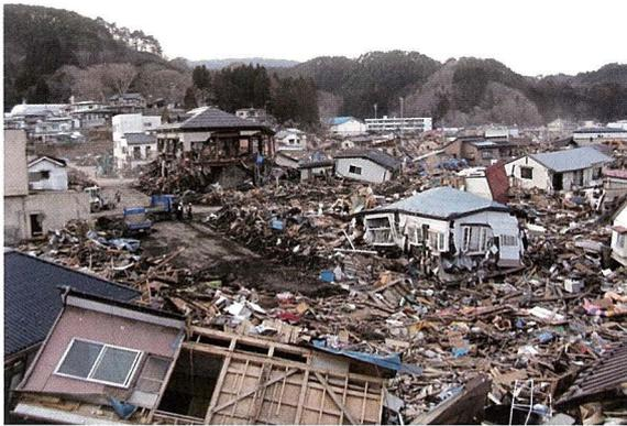
Photo 2. 全長 2300m 余・高さ 10m の堤防を超えた津波に破壊された宮古市田老地区の家並み (2011年3月28日, 土井宣夫氏撮影).
