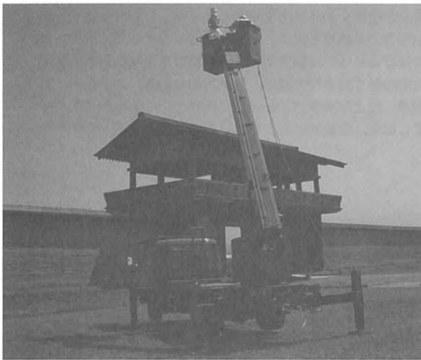
図2 高所作業車を使用した計測風景
