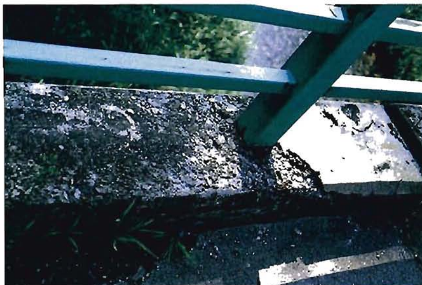
写真 1-1 地覆に生じた中程度のスケーリング
