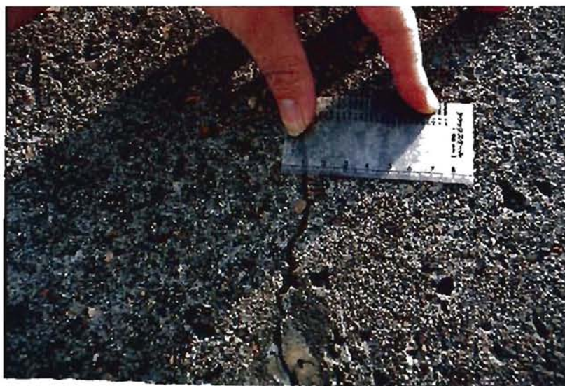
写真 1-4 空気量の減少によるひび割れ
