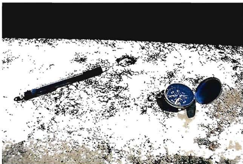
写真 1-3 ポップアウトによる損傷
