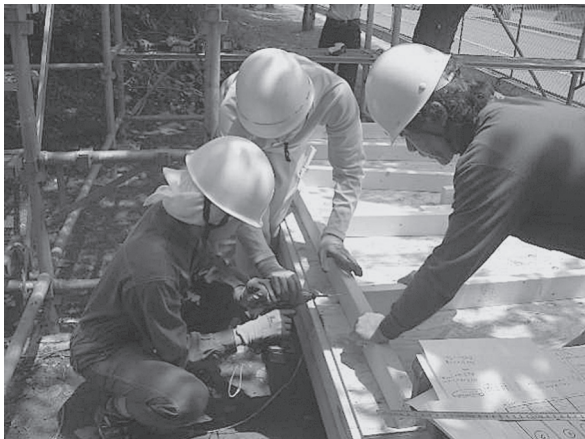
写真5 ビスを打ち込む様子
