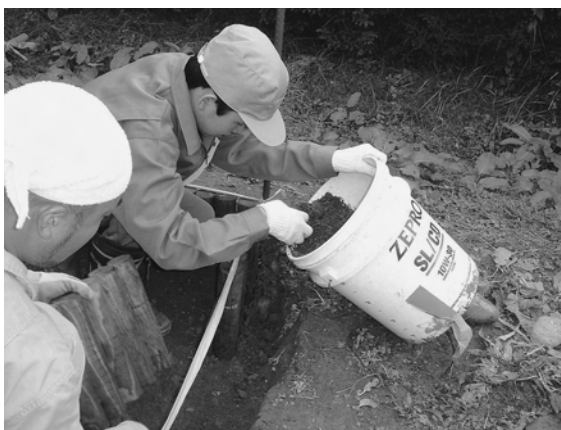
写真3 花壇の杭を設置する様子
