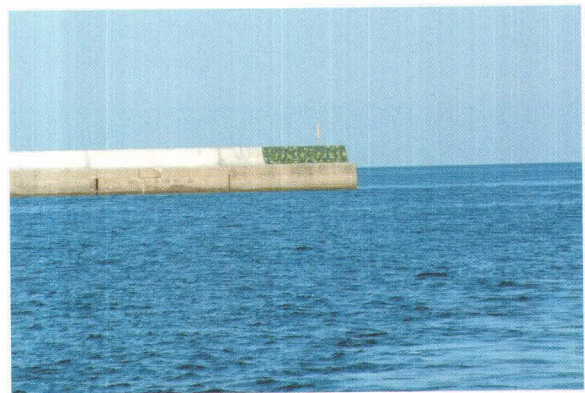
〔写真5〕 防波堤近景1
