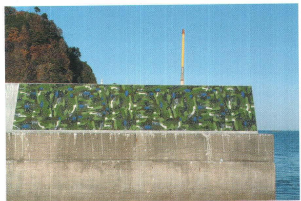
〔写真6〕 防波堤近景2
