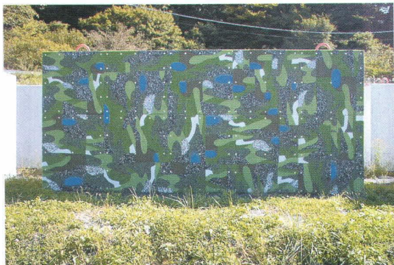
〔写真3〕 根固めブロックへの取り付け完成図1
