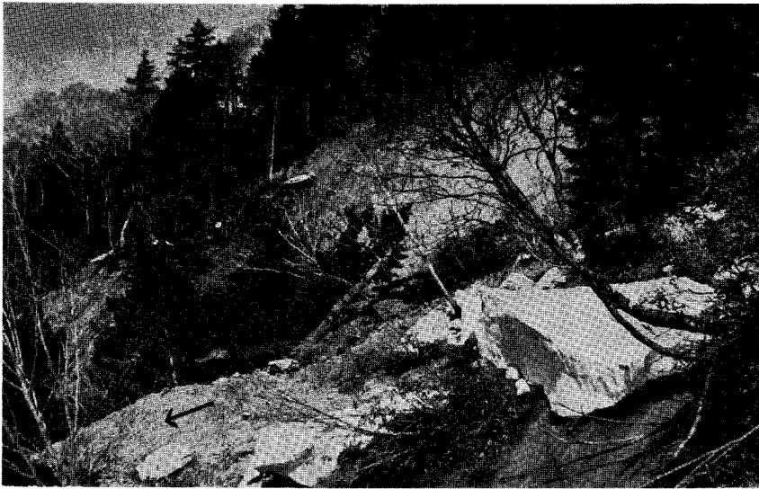
第4図 地すべり頭部の崩壊の状況。すべった斜面の傾斜は 25^{\circ} 以上で、可成りの土塊が崩落し、樹木も倒されながらすべった。
