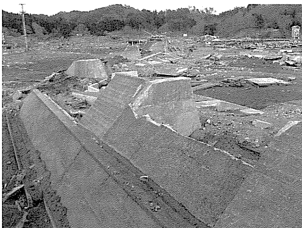
図 31: 宮古市田老の破壊された防潮堤。田老町の防潮堤は高さ 10m で、増築されて X 字型を呈している。津波はすべての防潮堤を越えて住宅地に侵入したが、津波の進行方向に高角度で交わる新しい防潮堤は海側に倒壊し、防潮堤背後の住宅はその基礎を残してすべて流失した。宮古市田老町，20110328 撮影。
