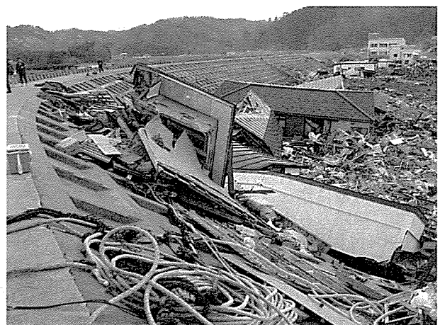
図 32: 宮古市田老の破壊されなかった防潮堤。津波の進行方向に低角度で交わる古い防潮堤は、越流されたが破壊、洗掘されることなく、防潮堤の背後の住宅も全壊（流失）から半壊であった。このことは津波の進行方向に低角度で交わる（平行に近い）防潮堤ほど施設の効果を発揮することを示している。宮古市田老町，20110328 撮影。
