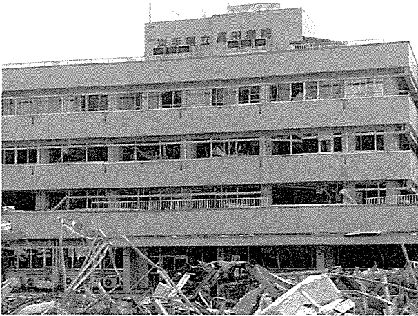
図 15: 津波が 4 階病室まで到達した陸前高田病院。海（南）側に面する病室の窓ガラスは 4 階まで割れ、北側の 4 階窓ガラスは割れていない。津波当日、岩手在住の津波研究家・山下文男氏は、4 階病室で津波に襲われたが津波に耐え、屋上に救出されたあと、翌日救助された。陸前高田市中堰，20110328 撮影。
