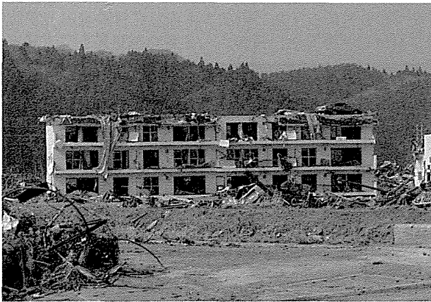
図 17: 3 階ビル屋上にのる乗用車。ビル 3 階を越える浸水深を示す。宮城県南三陸町志津川，20110414 撮影。
