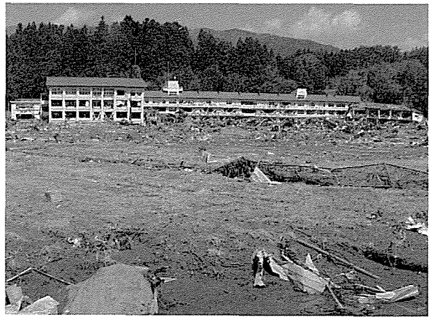
図 16: 海岸平野のもっとも丘陵寄りにあり、3 階まで被災した陸前高田高校。高校の地盤高度は約 4m. 陸前高田市長砂，20110328 撮影。
