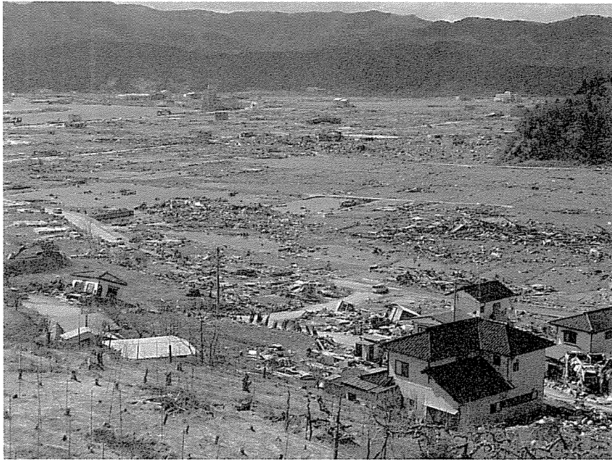
図 14: 陸前高田市の津波被害の状況。低平な海岸平野にあった市街と JR 大船渡線などは、ビルを残してすべて破壊され、平野が見渡せる状態になった。また地盤の沈降により湛水している地区がみられる。20110328 撮影。
