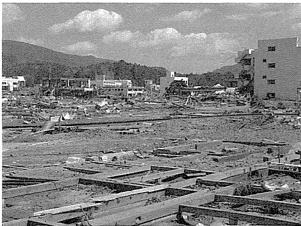
図 11: 基礎のみを残して流失した木造家屋。陸前高田駅前，20110328 撮影。
