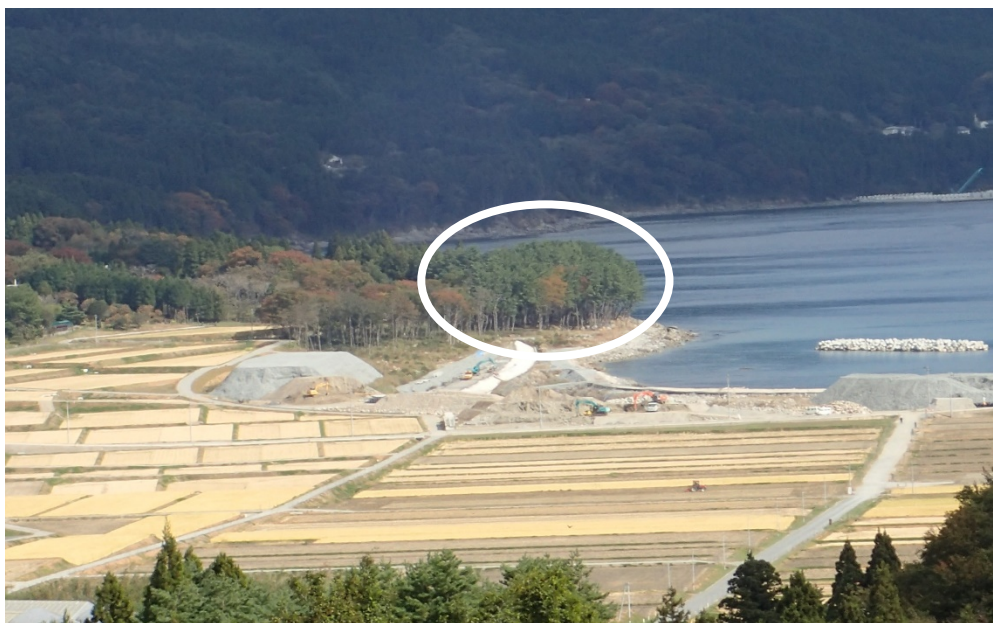
図 2.2 調査対象地の位置と遠景（白線内が調査対象地） 遠景の撮影日は 2015/10/14
