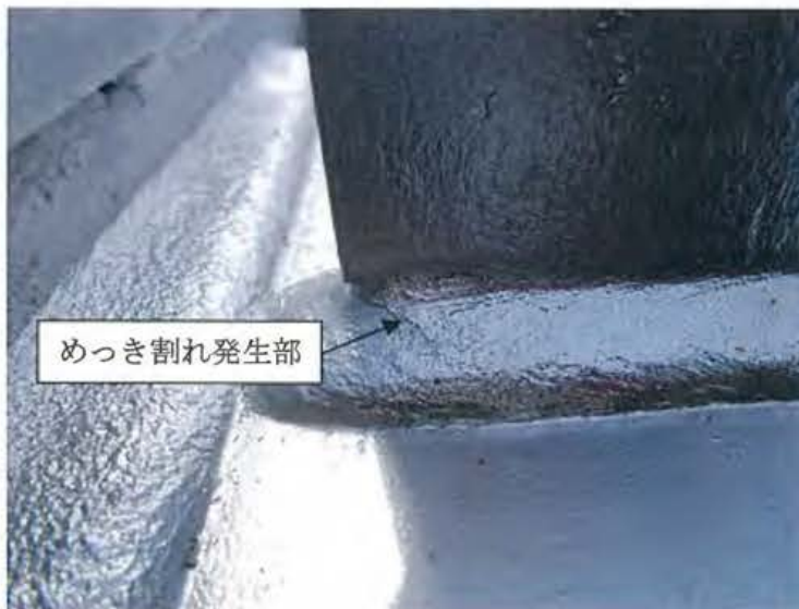
図 1-1-4 柱材の溶接部めっき割れ拡大図
