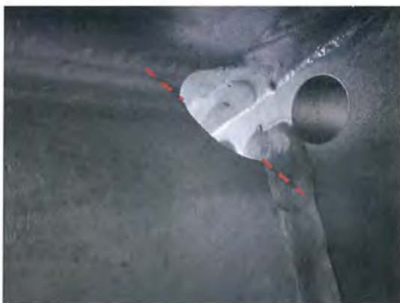
図3-4-2 スカラップ部のめっき割れ発生状況
