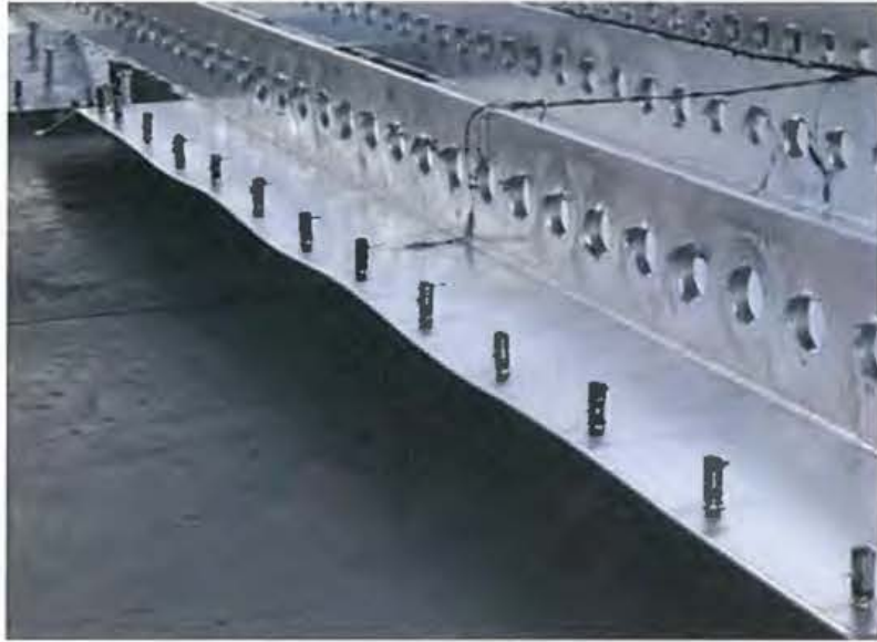
図 5-2-8 底板端部に発生した局所変形
