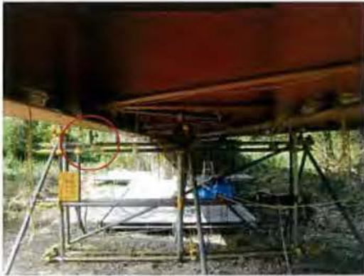
写真-2.3 支間中央主桁部の 変位計設置状況
