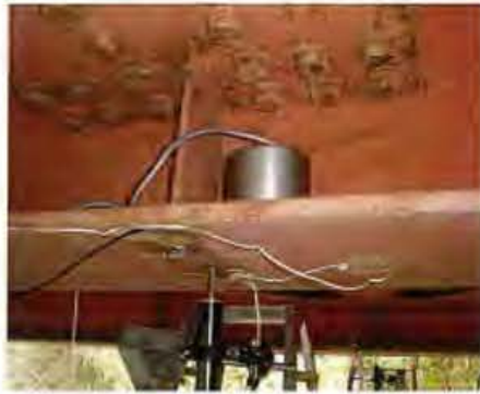
写真-3.3 速度計設置状況
