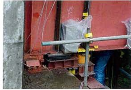
写真-2.15 仮設ゴム支承設置状況
