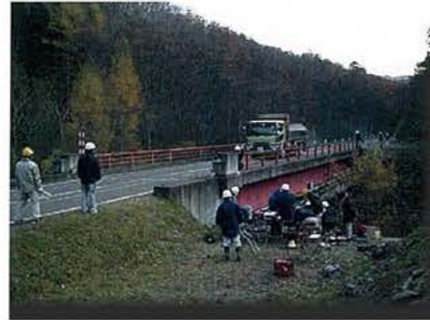
写真-2.9 動的載荷試験の状況 (車両走行試験)
