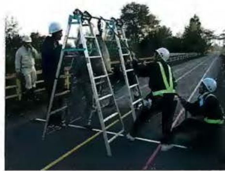
写真-3.4 砂袋落下試験状況
