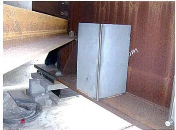
写真-2.11 高精度傾斜計の設置状況
