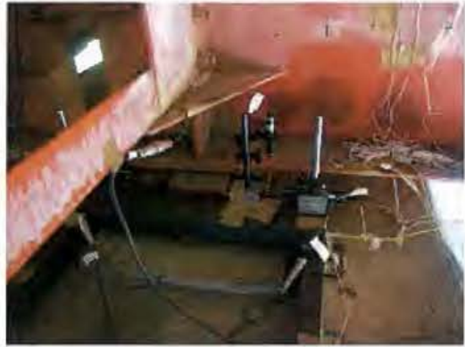
写真-2.4 支点部の変位計設置状況
