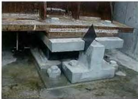
写真-2.12 固定支承の拘束
