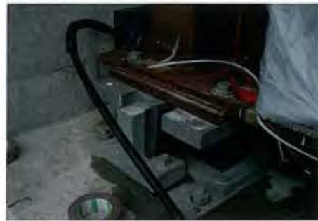
写真-2.13 可動支承の拘束
