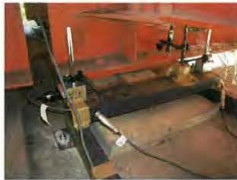
写真-4.2 支承部変位計設置状況
