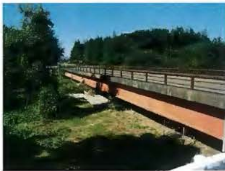
写真-4.1 現場状況
