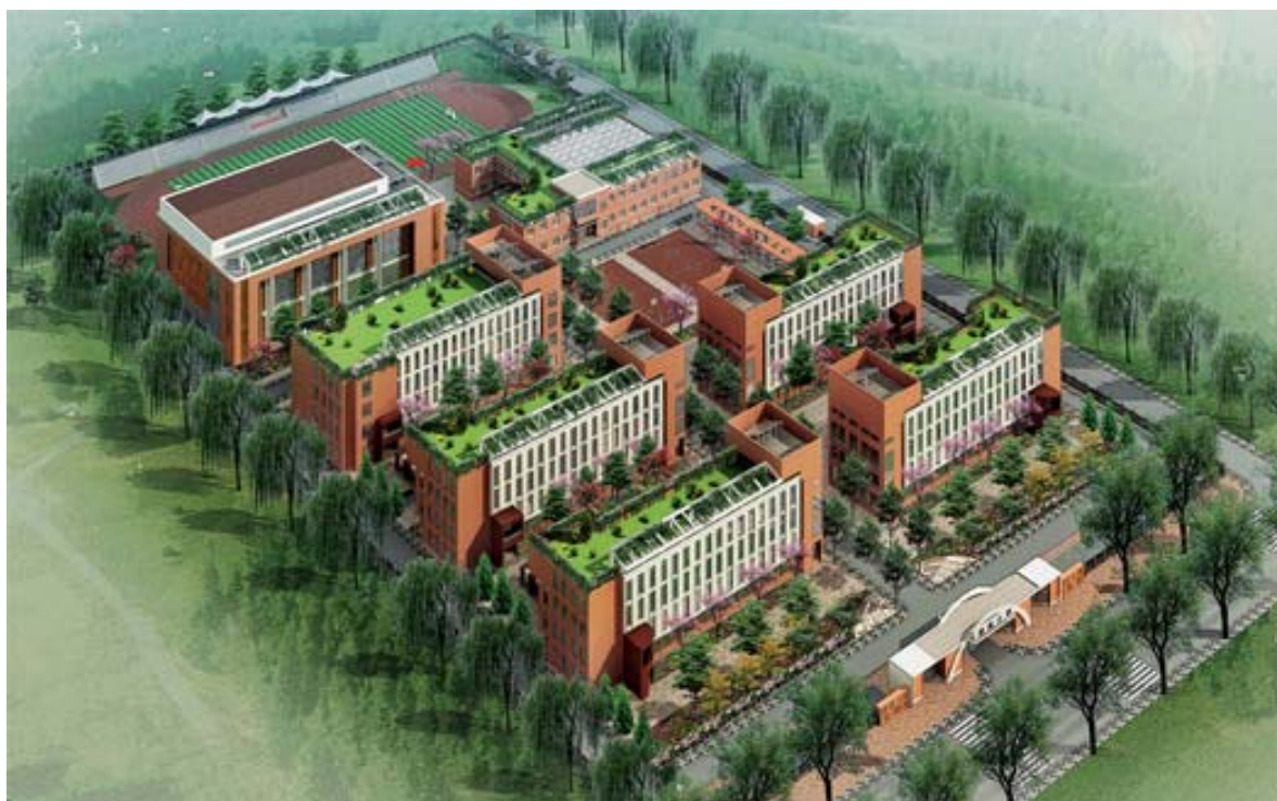
写真 3-1 淮海小学校校舎改造完成図。
