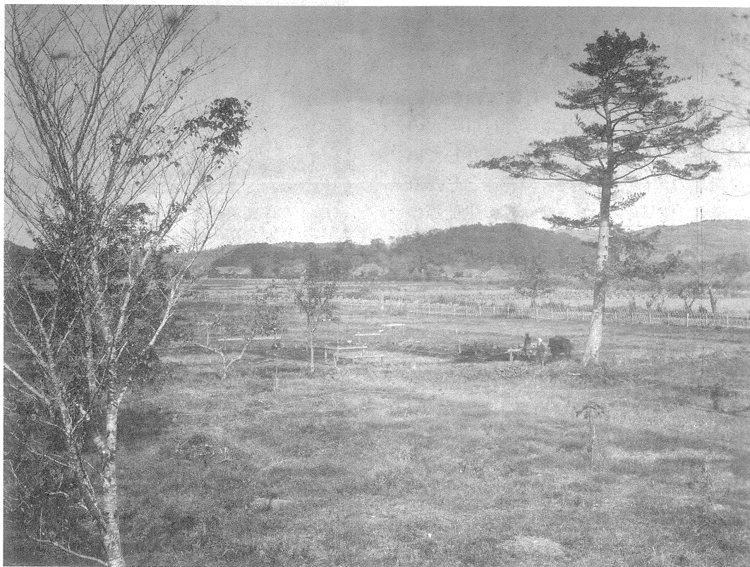
写真2 杭打ちした建築敷地から北方面「八幡山・毛無森山（高松神社）・高松池」を望む（明治34年秋）
