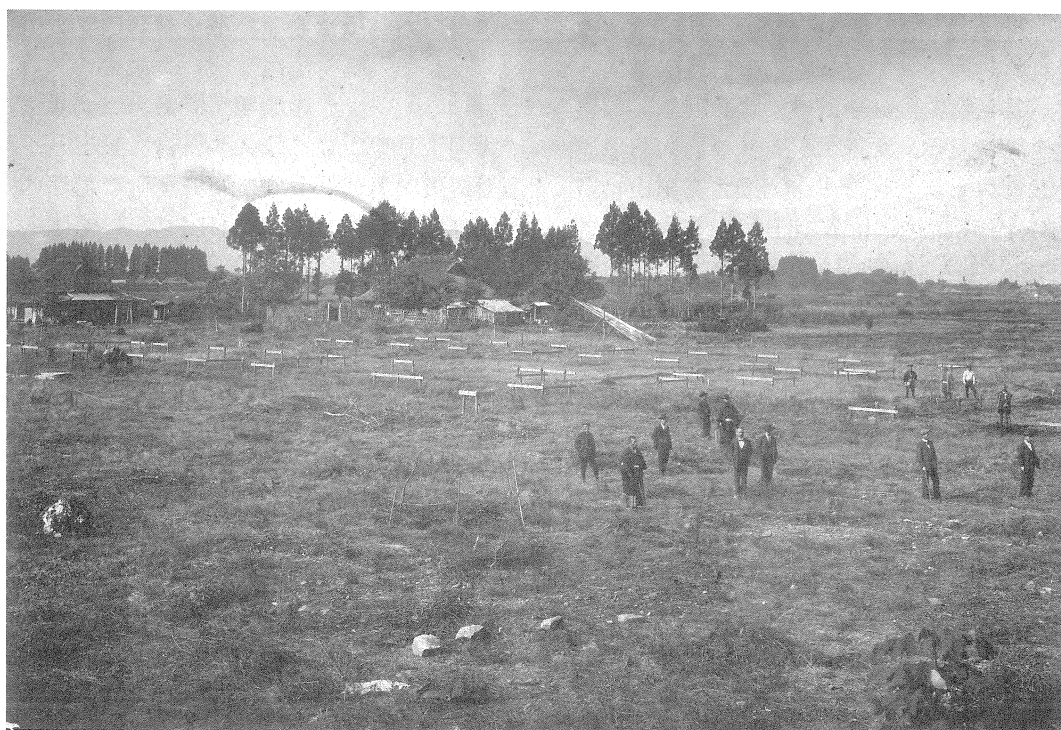
写真3 杭打ちした建築敷地から西南方面を望む（明治34年秋）：背後に家屋や樹林、視察中の人物が見られる。
