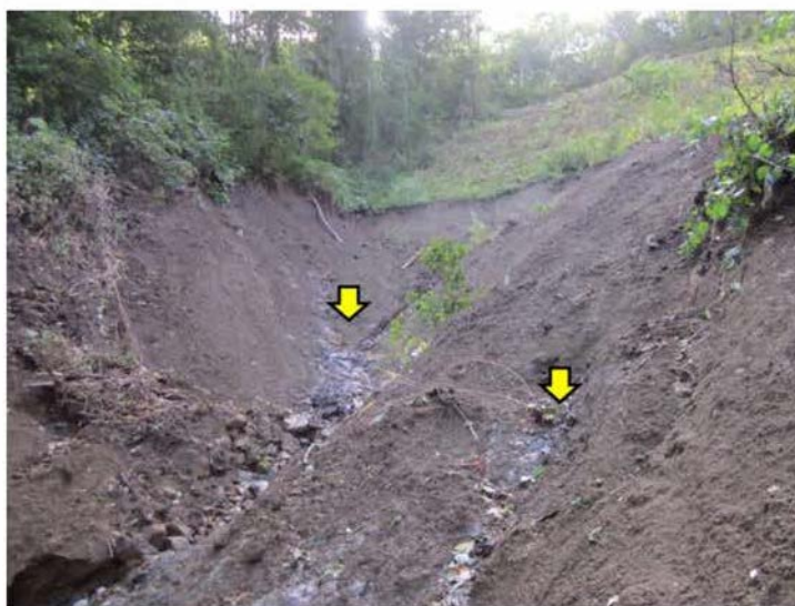
Photo V-1 2015 年 9 月の関東東北豪雨の際に第三章 Fig. Ⅲ-2 近傍の斜面で発生した崩壊。矢印の位置より湧水が認められる。
