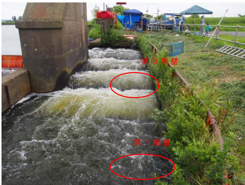
図 2-4 調査対象魚道全景（下流側から望む）
