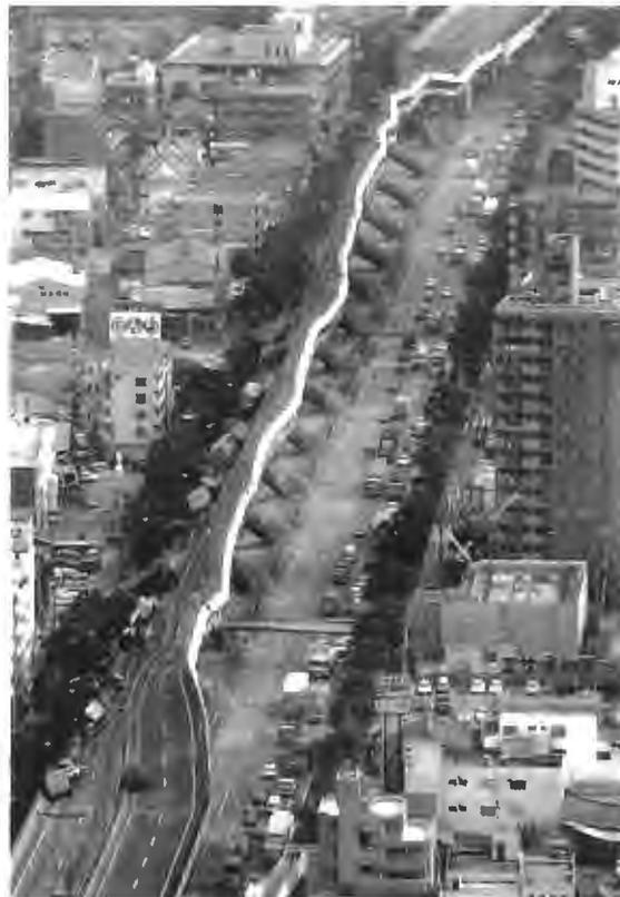
写真2 倒壊している阪神高速道路
