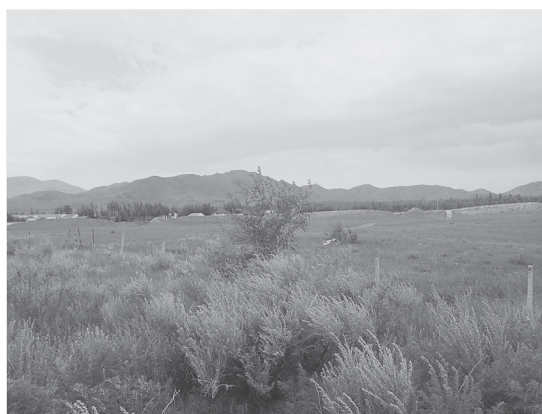
図 10 慶州故城の城壁址
