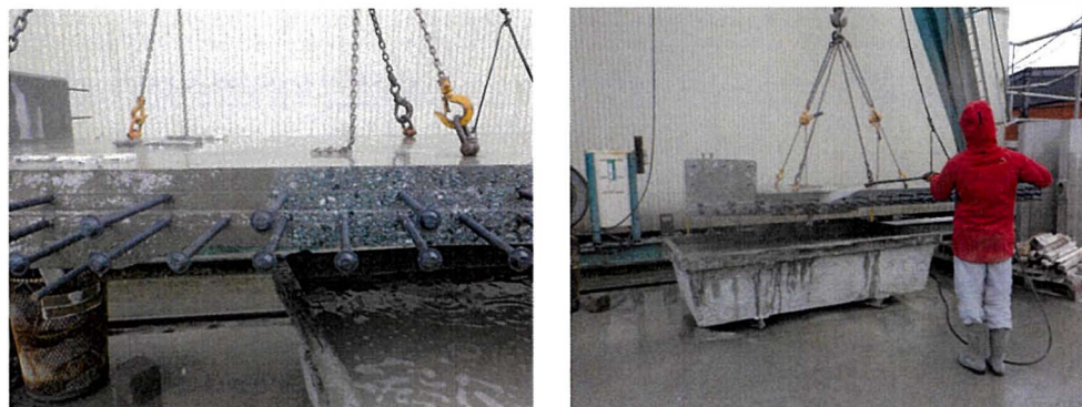
図-5.4.3 継手部目荒し状況
