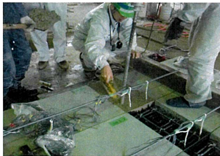
図-4.1.5 継手部 Co 打設
