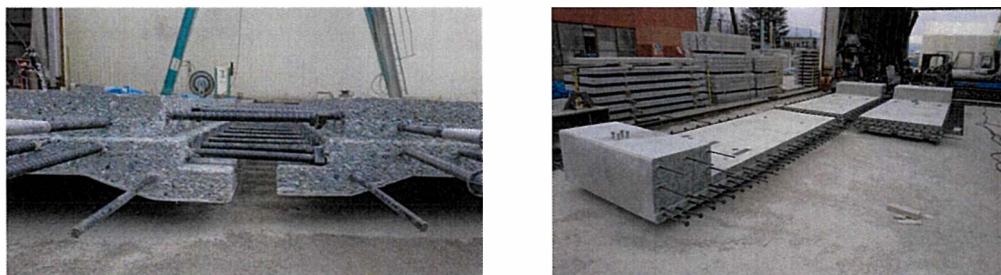
図-5.4.4 仮組立状況
