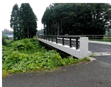
図-2.2 A橋側面（補修済橋梁）
