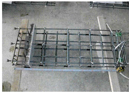
図-4.1.3 配筋状況（主筋）
