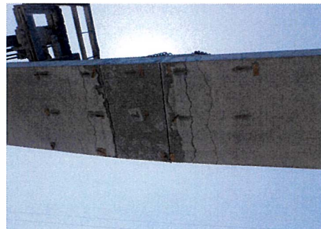
図-4.1.21 4点曲げ試験破壊状況 (継手あり)
