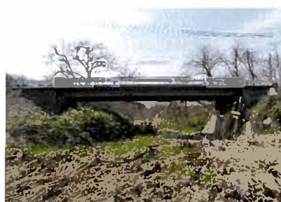
図-2.4 B 橋側面（未修繕橋梁）
