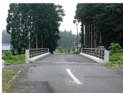
図-2.1 A橋正面（補修済橋梁）
