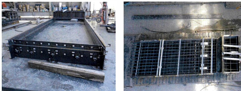
図-5.4.1 採用した型枠と配筋状況
