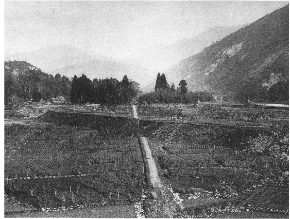
図4 濃尾地震の震源断層写真 (ジョン・ミルン『The Great Earthquake in Japan, 1891』)
