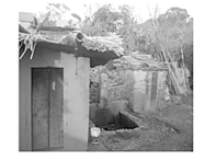
震災前に完成した水道
