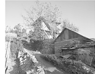
地震で破壊されなかった住居
