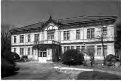
図2 耐震改修前の資料館(平成24年4月25日)
