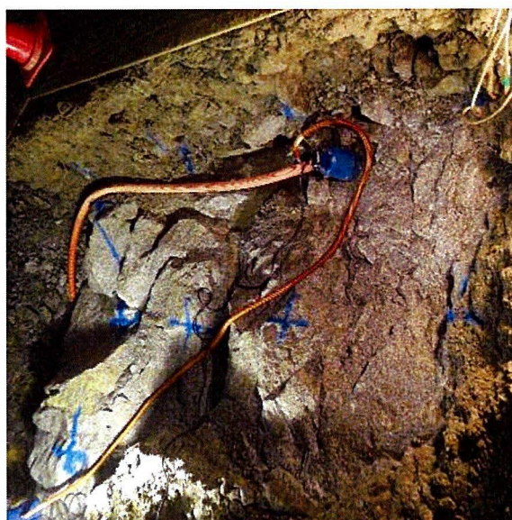
写真 3.8.2 掘削面全体写真
