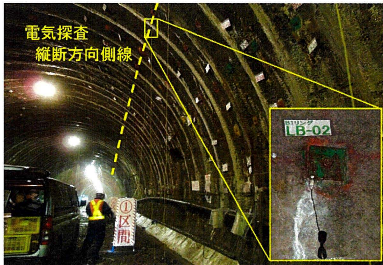
写真 3.9.5 グ라우チング施工前の電気探査実施状況
