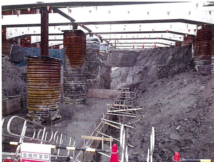
写真 5.3.1 先行仮設コンクリート打設前
