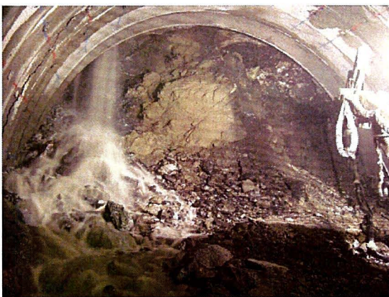
写真 3.2.1 貫入境界付近の掘削時の大量湧水状況(TD1,807m)
