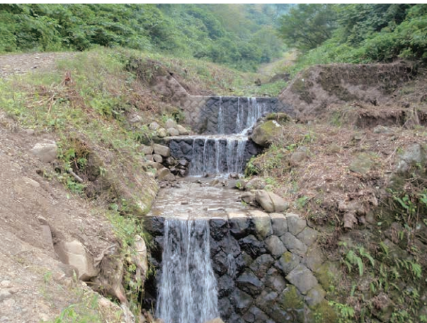
図-5 現存する日影沢床固工群
