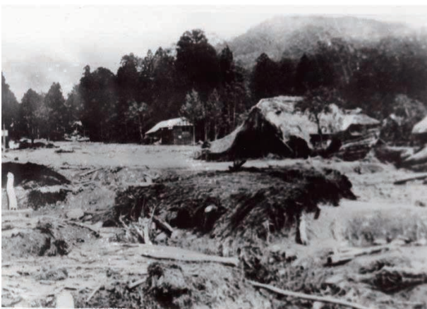
図-3 「山のげ」による集落の被災状況 12) (1902年(明治35年)5月に撮影された現存する唯一の写真)
