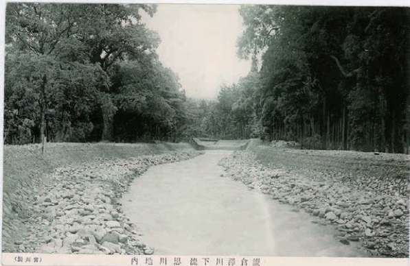
図-8 竣工直後（1936年頃）の鎌倉沢川砂防流路工 21) Fig.8 Kamakurasawa River Sabo Channel works (1936) 21)
