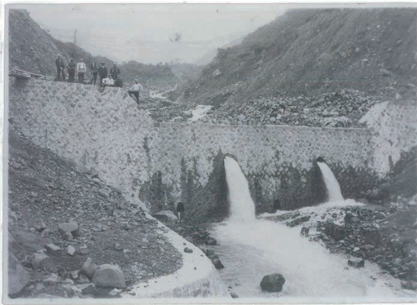
図-4 竣工直後（1924年頃）の万内川一号堰堤 12)
