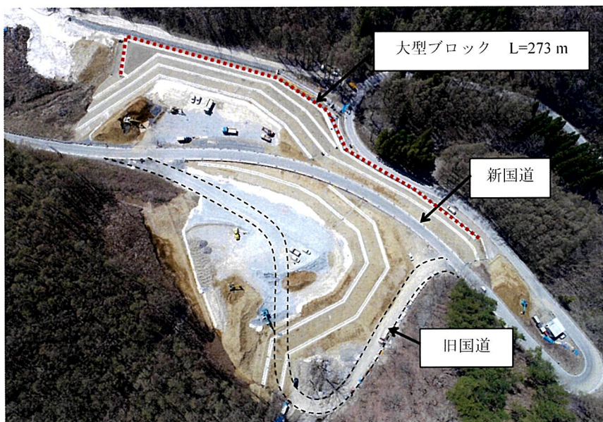
写真 3.2.1 掘削ずり処分場の施工状況
