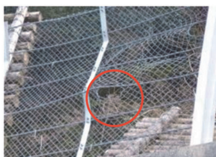
写真－1 落石が金網を突き抜けた事例 （調査日2016年3月6日） Photo 1 Example of a falling rock penetrating a wire net （survey date March 6 2016）
