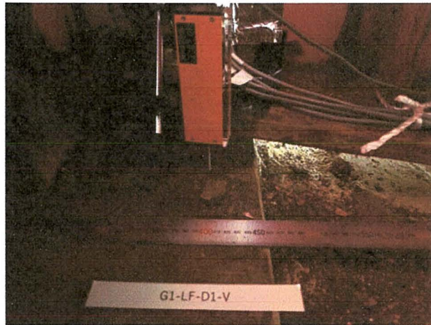
写真-2.7 鉛直変位計設置例（支承部付近：床版取替前）
