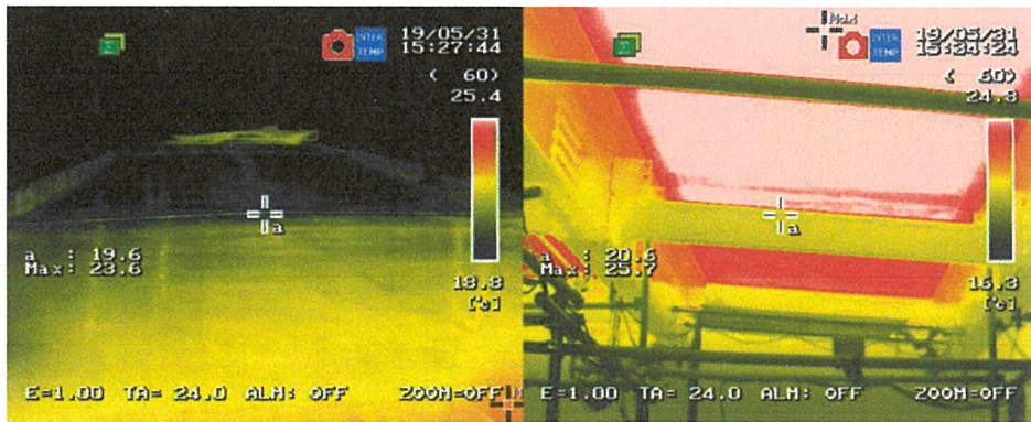
写真-付.23 床版取替後赤外線サーモグラフィー画像 (左：舗装表面，右：床版下面及びび桁，2019年5月31日15:30)
