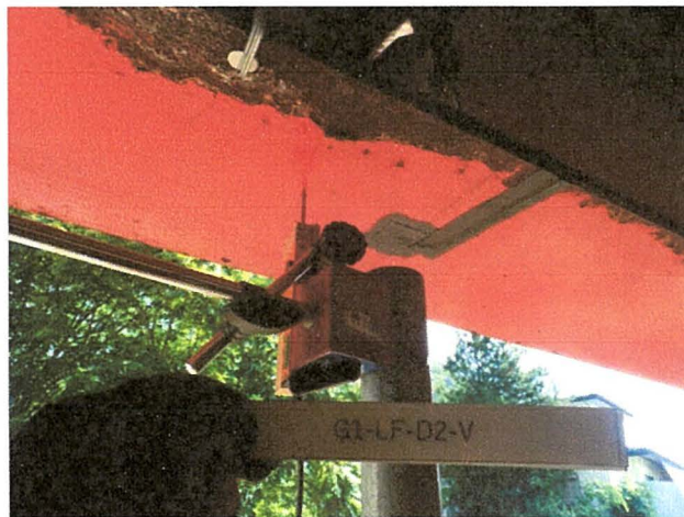
写真-2.8 鉛直変位計設置例（支間 1/4 点）
