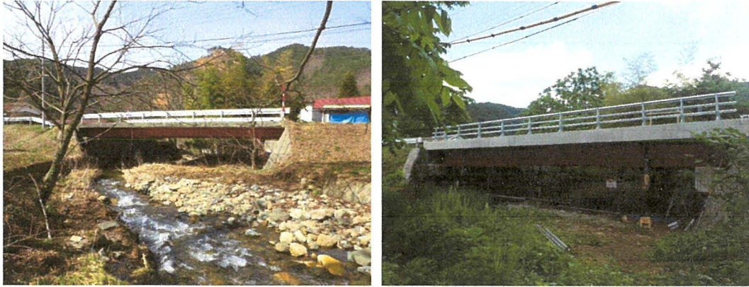
写真-2.1 対象橋梁全景（左：床版取替前，右：床版取替後）
