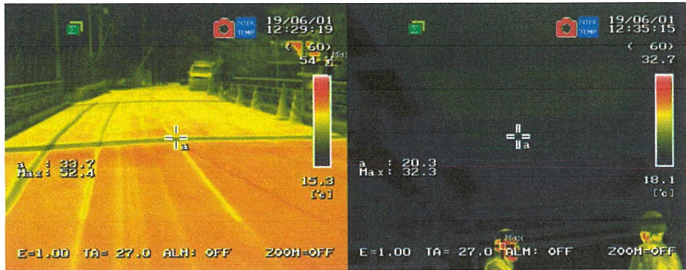
写真-付.43 床版取替後赤外線サーモグラフィー画像 (左：舗装表面，右：床版下面及び桁，2019年6月1日12:30)
