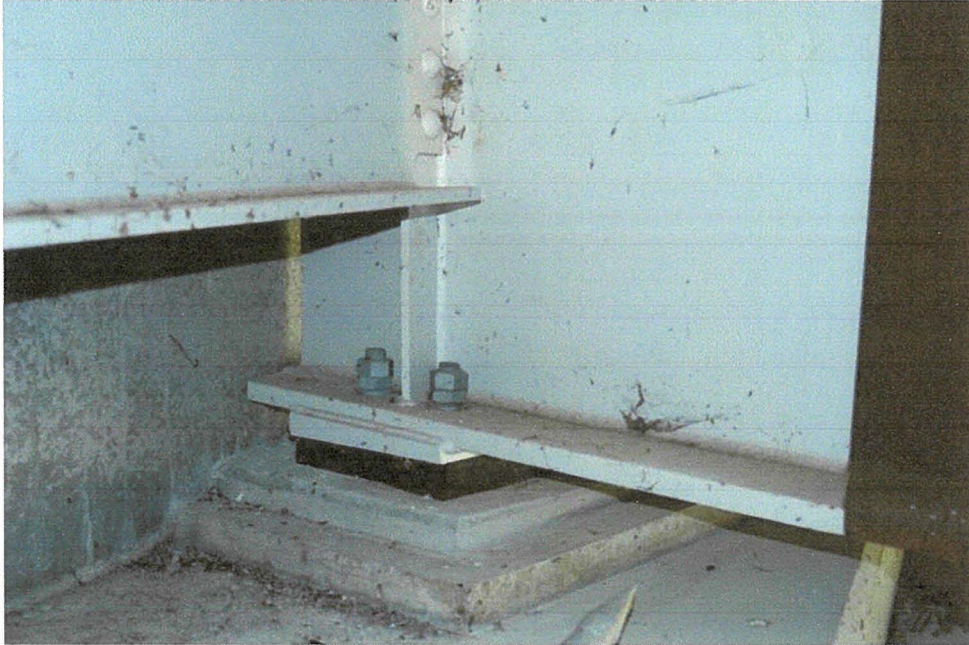
写真-1.3 対象橋梁現況写真（支承部）
