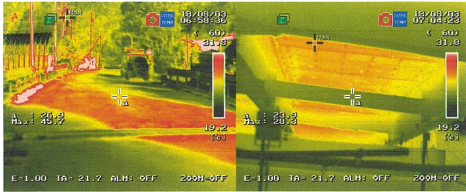
写真-付.19 床版取替前赤外線サーモグラフィー画像 (左：舗装表面，右：床版下面及び桁，2018年8月3日7:00)
