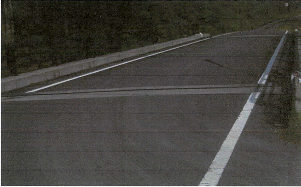
写真-1.2 対象橋梁現況写真（舗装上面）
