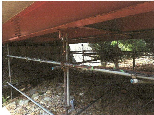
写真-2.11 橋体下部の足場設置状況
