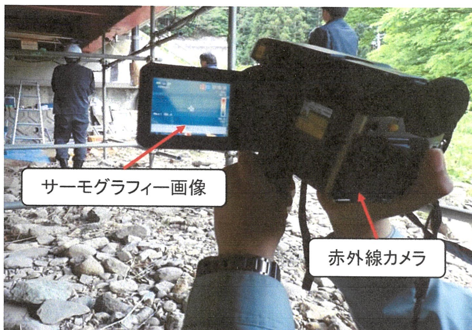
写真-3.1 赤外線カメラによるサーモグラフィーの撮影状況
