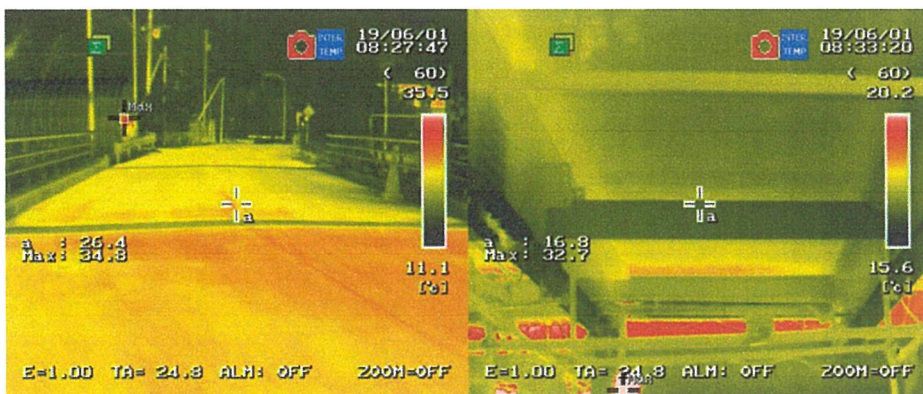
写真-付.39 床版取替後赤外線サーモグラフィー画像 (左：舗装表面，右：床版下面及び桁，2019年6月1日8:30)
