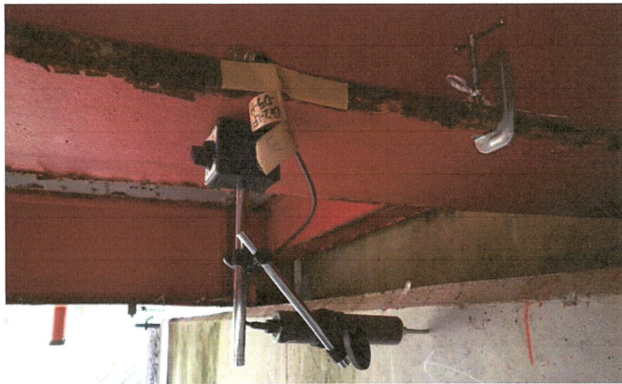
写真-3.7 支承部の変位計設置状況
