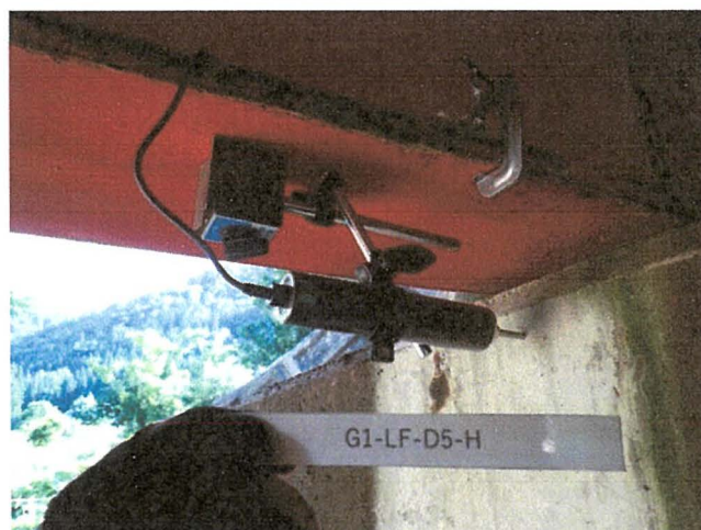
写真-2.9 水平変位計設置例（A2 支承側）
