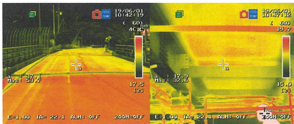
写真-付.41 床版取替後赤外線サーモグラフィー画像 (左：舗装表面，右：床版下面及び桁，2019年6月1日10:30)
