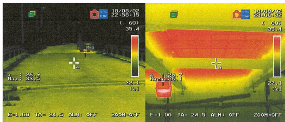
写真-付.11 床版取替前赤外線サーモグラフィ画像 (左：舗装表面，右：床版下面及び桁，2018年8月2日23:00)
