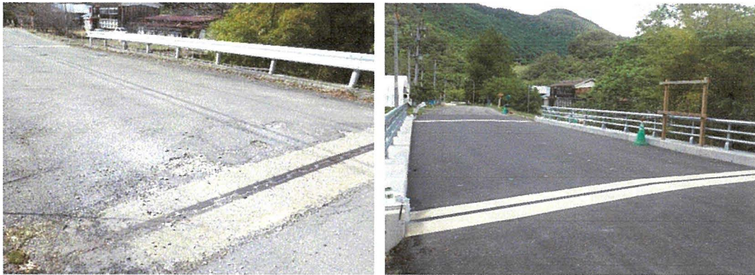
写真-2.2 対象橋梁路面状況（左：床版取替前，右：床版取替後）
