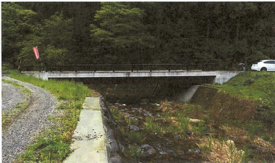
写真-1.1 対象橋梁現況写真（側面全景）
