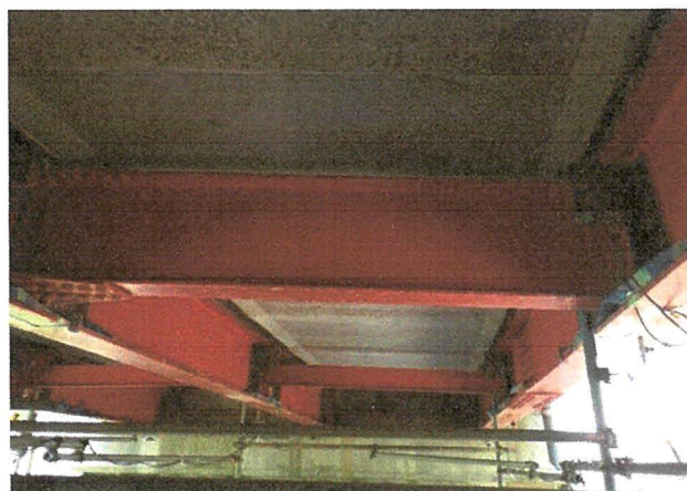
(b) 床版取替後
