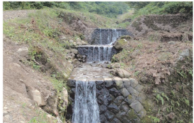
図一五 日影沢床固工群 (1926 (大正 15) 年頃完成) Fig. 5 Hikagesawa groundsels (Completed around 1926)
