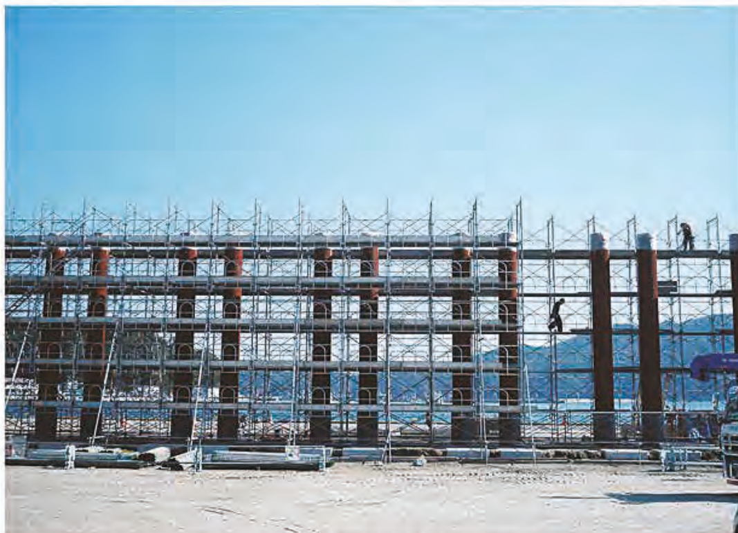
2015年10月 宮古市鍛ヶ崎 反対派と賛成派の意見がまとまることなく、巨大な防潮堤の建設が始まった。
