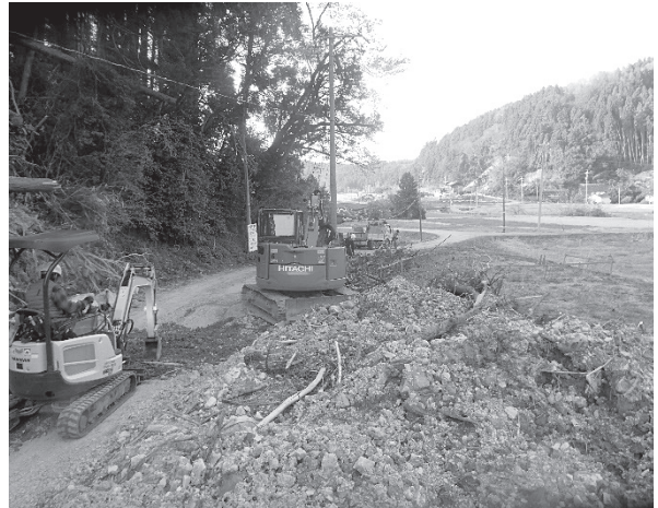
図1のE地点、南志見川下流部の谷壁斜面の崩壊により通行不能になった道路の修復作業風景
