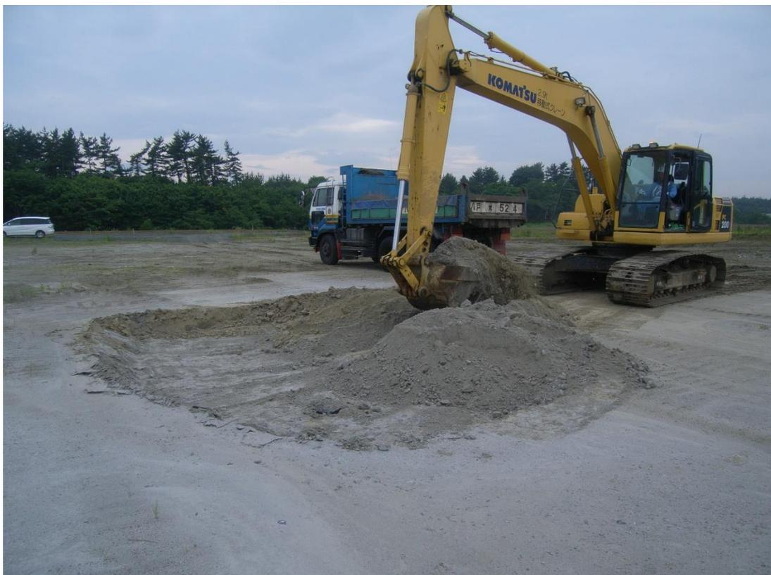
写真 5.2-3 軽石凝灰岩採取状況 (2010 年度)
