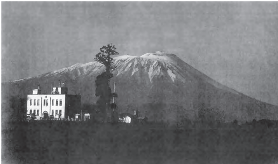
写真4 盛岡測候所と岩手山の遠景
