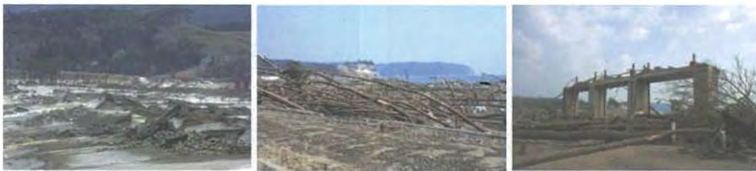
(a) 壊滅した防潮堤 (b) 倒木した防潮林 (c) 破壊された水門上屋
