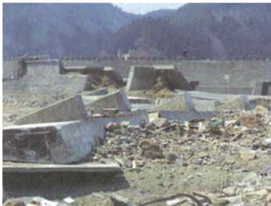
(a) 壊滅的に破壊された防潮堤
