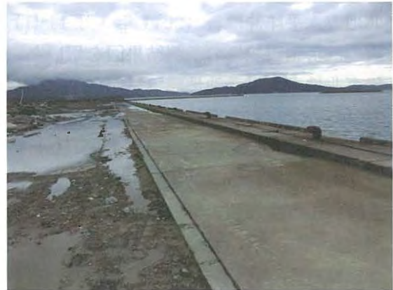
写真 4-1(b) コンクリート舗装の沈下と背後地の洗掘
