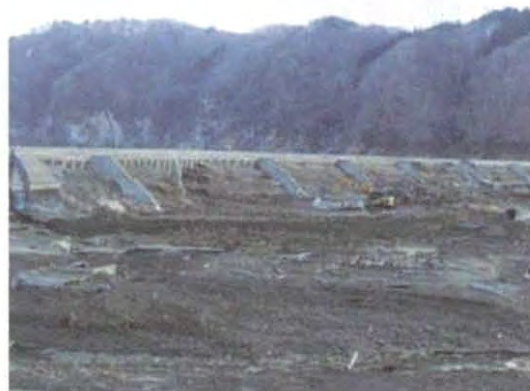
(b) 破壊された陸側法面の防潮堤
