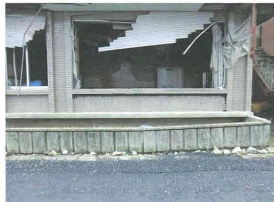
写真 4-1(f) 抜け上がりと不同沈下
