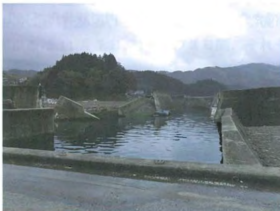
写真 4-1(e) 河川堤防の躯体転倒と埋立地の洗掘
