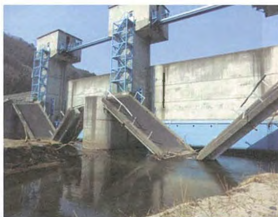
(a) 普代水門上流側の破壊された管理橋
