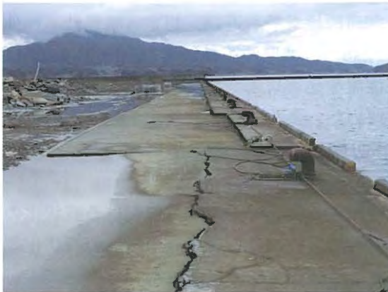
写真 4-1(a) 岸壁法線のせり出しとコンクリート舗装の曲げ破壊，沈下
