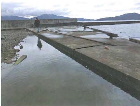
写真 4-1(c) 防波堤接合部の岸壁の滑動
