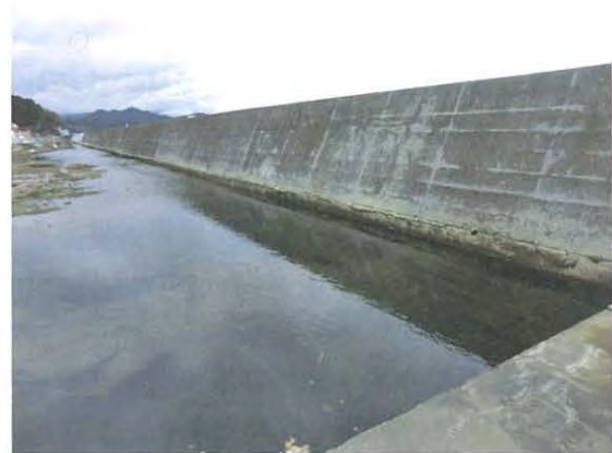
写真 4-1(d) 岸壁背後地の洗掘
