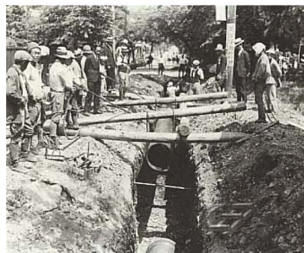
天神通送水管埋設工事 昭和8年（1933）6月撮影 盛岡みず物語より
