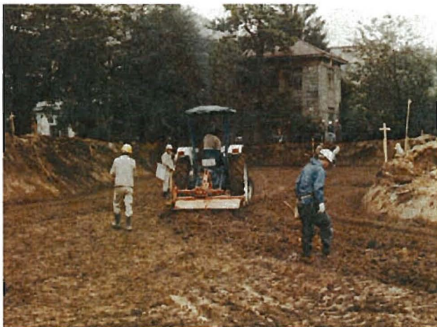
破碎転圧工法による池の工事 昭和55年（1980）
