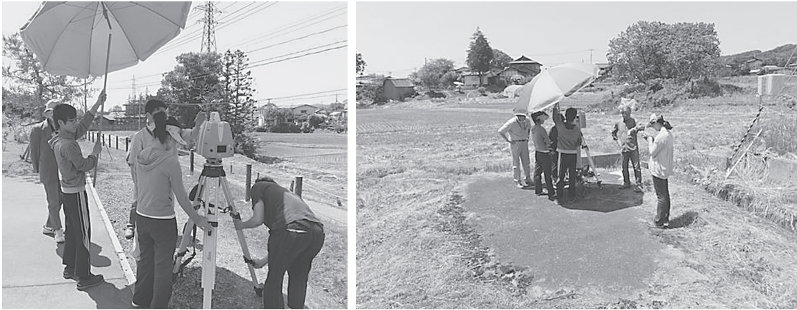
図6 3Dレーザースキャナの設置と計測（2013年6月3日）
