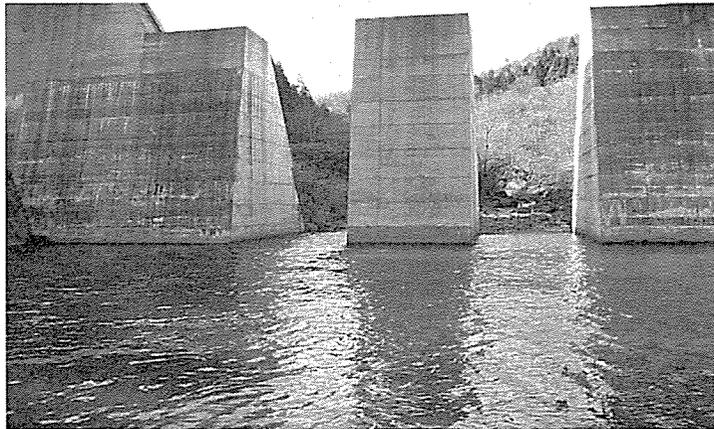
写真1 スリット式砂防堰堤正面図（下大森魚道）
