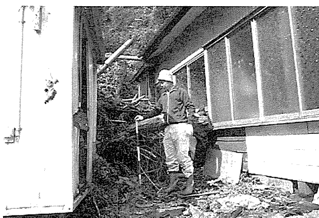
写真-5 浜町3丁目における土石流被災状況
