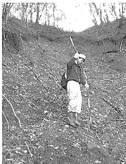
写真一 2 釜石市松原町松原の沢の源頭部に形成された表層崩壊
