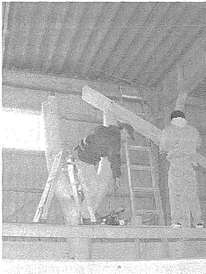
写真3 二股丸太と登り梁との接合
