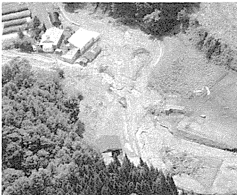
写真2 上空から見た横沢川及び鳥谷沢合流点の状況(上横沢地内)岩手県提供
