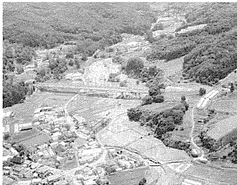
写真1 横沢川の氾濫による水田の浸水状況(尾呂部地内)岩手県提供
