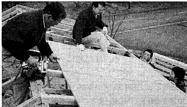
写真2 実験住宅への屋根下地（野地板）の施工
