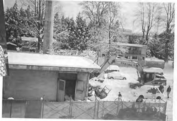
旧焼却炉解体 1999.1
