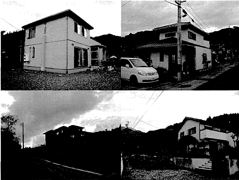
写真一２ 移転後の住居と斜面の状況（左上：大船渡市赤崎町、右上：釜石市浜町、左下：江刺区田原、右下：大船渡市赤崎町）
