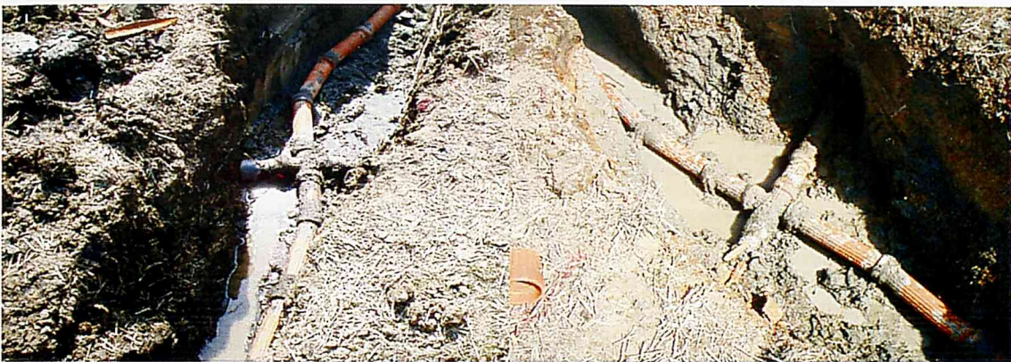
(a) 暗渠配管 (2003/4/15 撮影)
