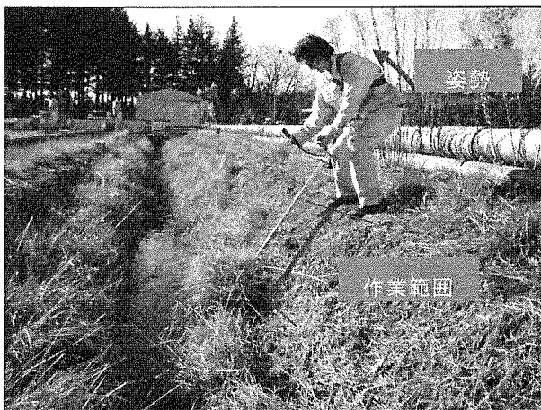
写真 5.2 法面上部からの草刈
